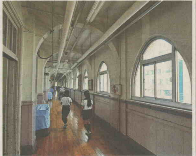
台東区立黒門小の耐震性とデザイン性を兼ね備えたアーチ形の窓と廊下の梁(はり)頑丈な鉄骨構造の築地市場。いずれも鳴邦夫撮影
